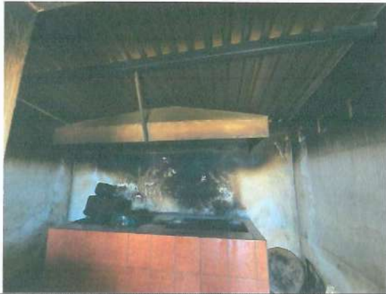
Foto1: REPARACIÓN O SUSTITUCIÓN DE ÁREAS DE COCINA
