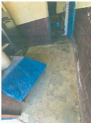
Foto 3: MEJORAMIENTO Y SUSTITUCION DE PISO
